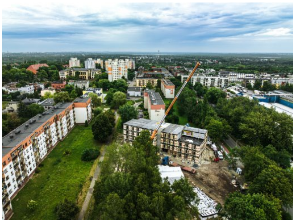
Efektywny energetycznie budynek wielorodzinny w Mysłowicach, Polska
